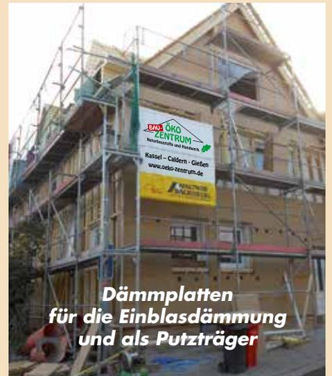
Dämmplatten für die Einblasdämmung und als Putzträger
