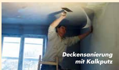
Deckensanierung mit Kalkputz
