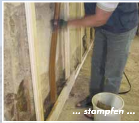
Lehm in Schalung einfüllen ...
