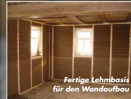
Baubiologisch und bauphysikalisch empfehlenswerte Innendämmung eines Fachwerkhauses
