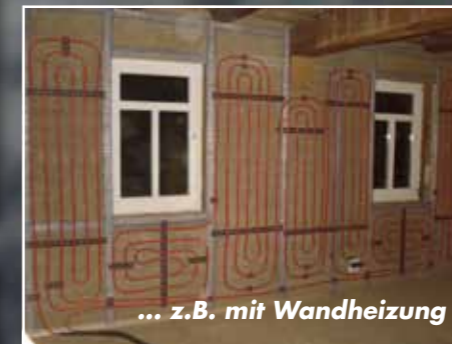
Lattung mit Wandabstand für die erforderliche Dämmstärke
