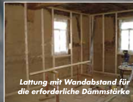
Baubiologisch und bauphysikalisch empfehlenswerte Innendämmung eines Fachwerkhauses
