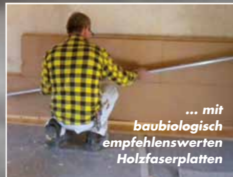
Innendämmung von Außenwänden
